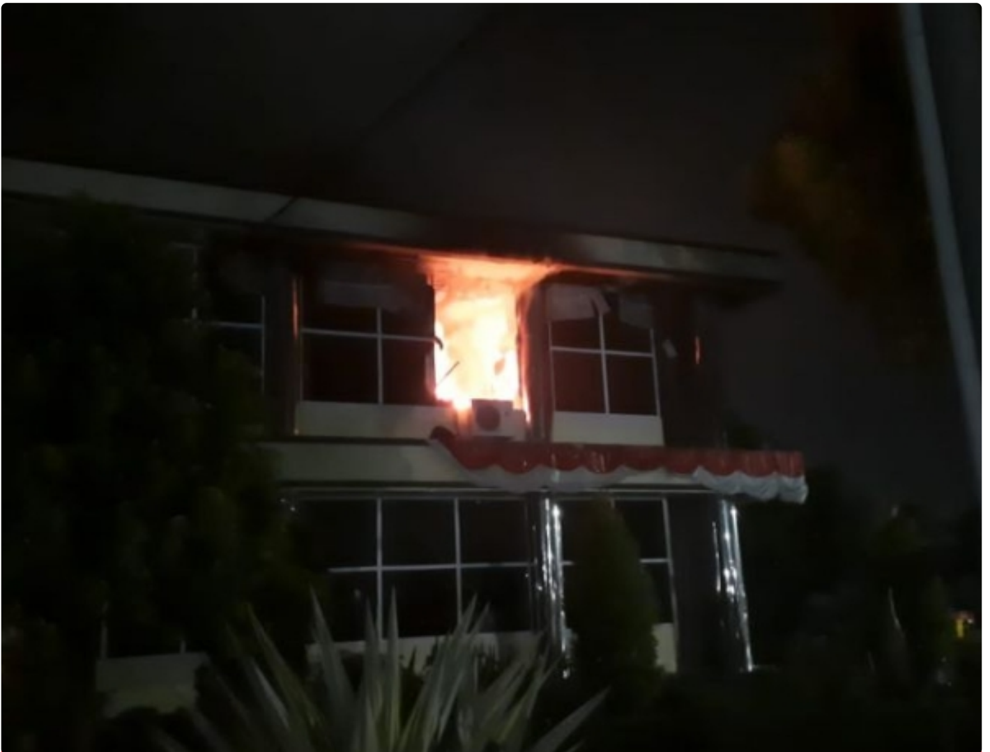
Diduga arus pendek, Gedung Ditreskrimsus Poldasu Terbakar, Kamis (25/8).
